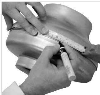
1. Markera ut **B**-måtten på fläktens ihopsättningsskant till skruvhål (C).
