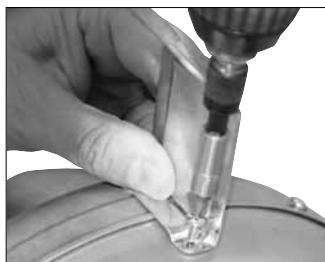
3. Skruva fast konsolerna med de självborrande skruvarna (förborrning behövs ej).
