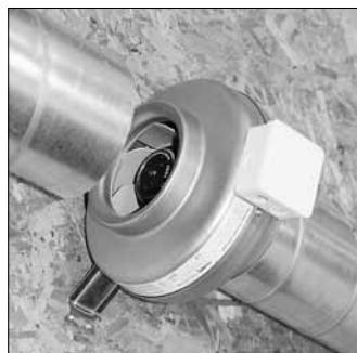
2. Rohre und Ventilator zusammensetzen.
