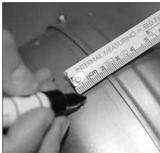
2. Anschließend die **C**-Maße markieren. Bei der Messung von der Überlappungsstoßkante des Ventilators ausgehen.
